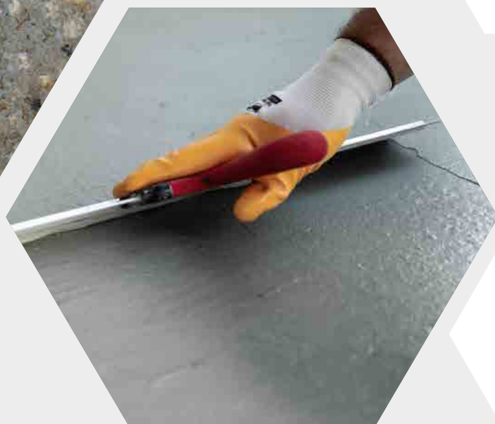
Uszczelnianie posadzek, balkonów i tarasów
