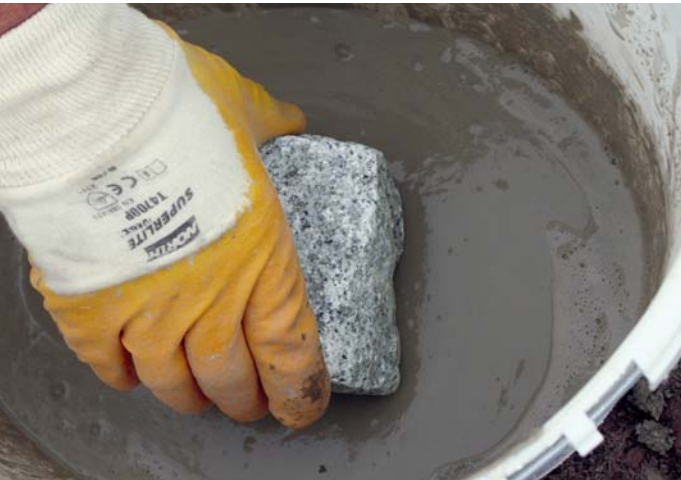
Szlam kontaktowy TNH-rapid należy nanieść bezpośrednio na spodnią część elementu brukowego lub płyty.
