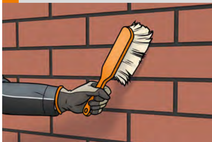
6 Czyszczenie powierzchni muru
