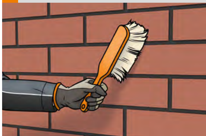
6 Czyszczenie powierzchni muru
