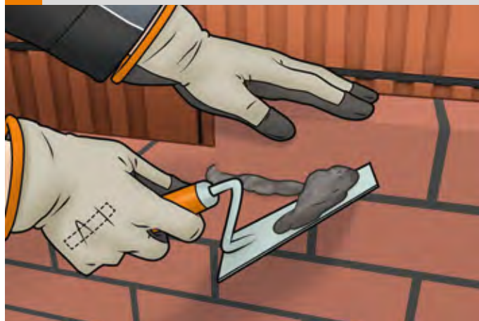
2 Zbieranie nadmiaru zaprawy murarskiej
