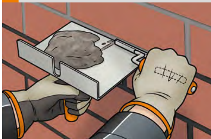
4 Wypełnianie spoin poziomych zaprawą FM T
