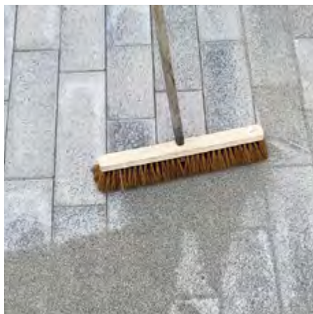
Aplikacja piasku polimerowego ESP.
