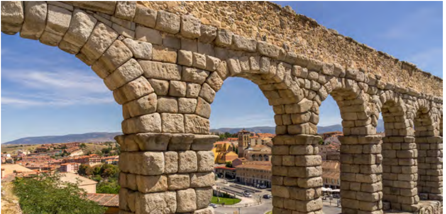
Pozostałości akweduktu wzniesionego przez Rzymian. Akwedukt wymurowano na zaprawie wapiennej modyfikowanej trasem reńskim.
