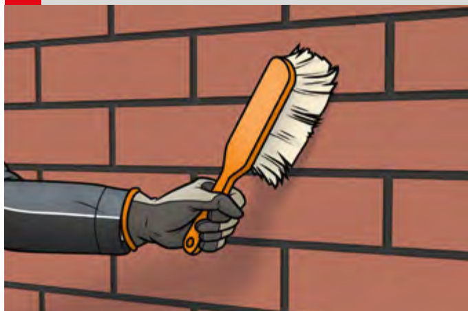
6 Czyszczenie powierzchni muru
