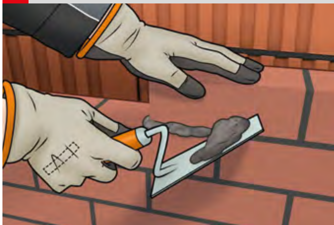
2 Zbieranie nadmiaru zaprawy murarskiej
