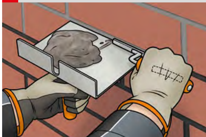
4 Wypełnianie spoin poziomych zaprawą FM T
