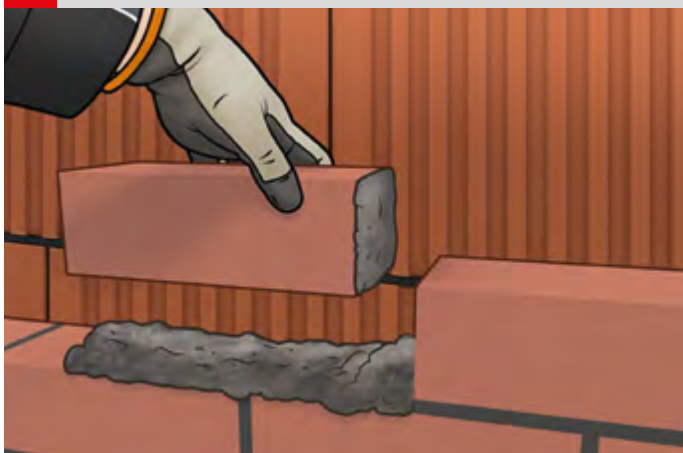
1 Układanie cegły na zaprawie murarskiej HM 2a T
