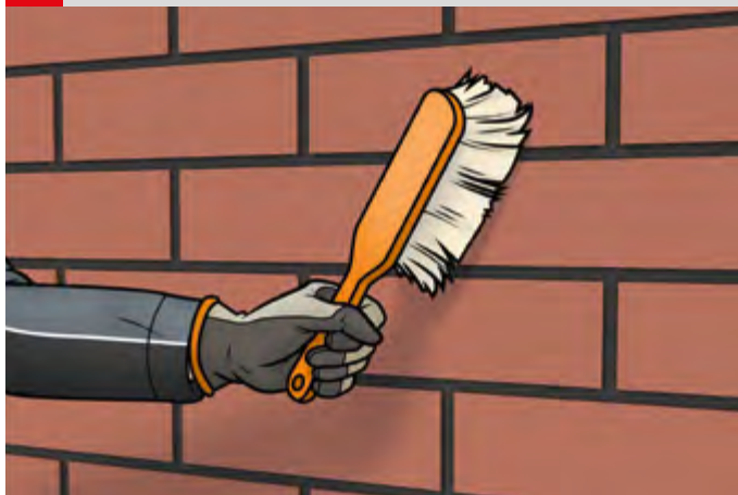
6 Czyszczenie powierzchni muru
