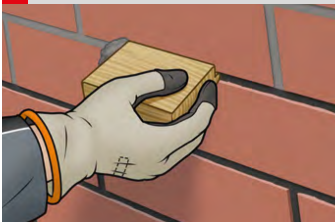
3 Usuwanie zaprawy murarskiej na głębokość ok. 10-15 mm
