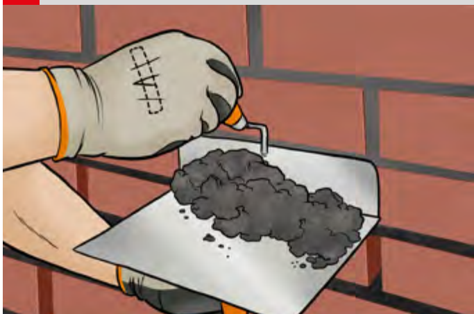
5 Wypełnianie spoin pionowych zaprawą FM T
