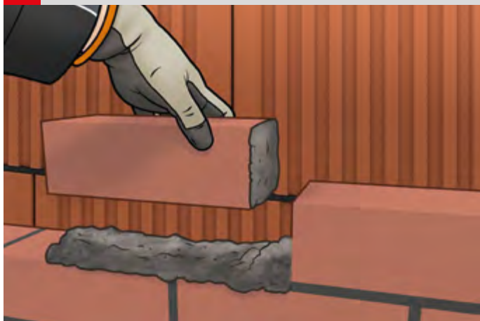
1 Układanie cegły na zaprawie VM 01 T lub VK Plus T
