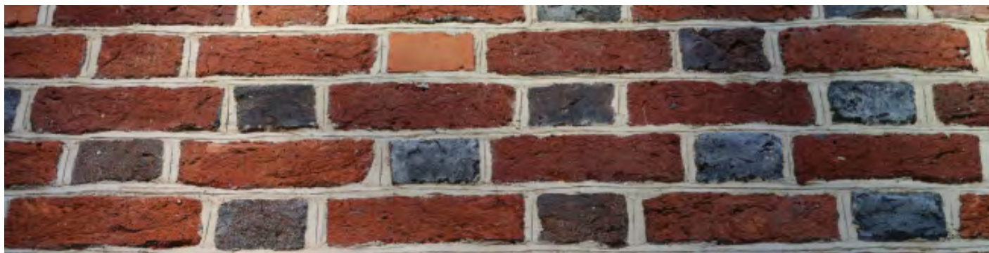
Cegła spoinowana zaprawą wapienną NHL-F
