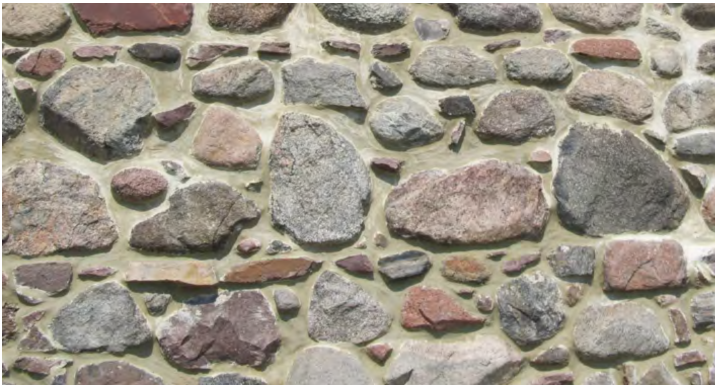
Mur kamienny murowany zaprawą NHL-M
