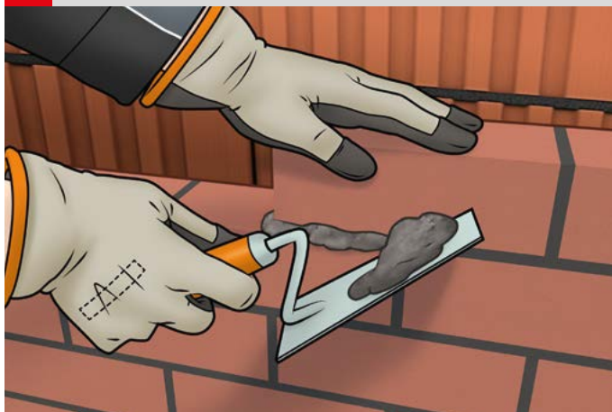
2 Zbieranie nadmiaru zaprawy murarskiej
