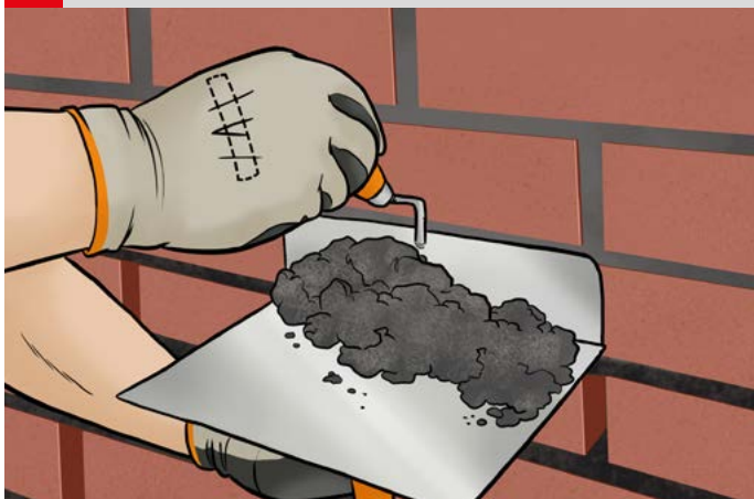
5 Wypełnianie spoin pionowych zaprawą FM T
