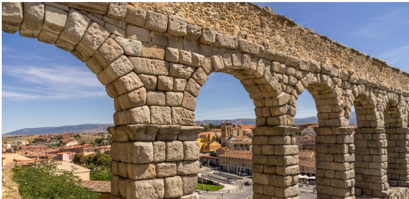
Pozostałości akweduktu wzniesionego przez Rzymian. Akwedukt wymurowano na zaprawie wapiennej modyfikowanej trasem reńskim.
