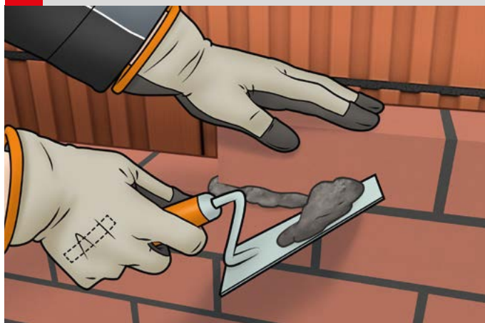
2 Zbieranie nadmiaru zaprawy murarskiej HM 2a T
