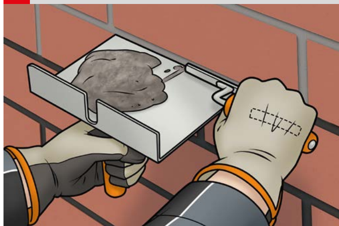
4 Wypełnianie spoin poziomych zaprawą FM T
