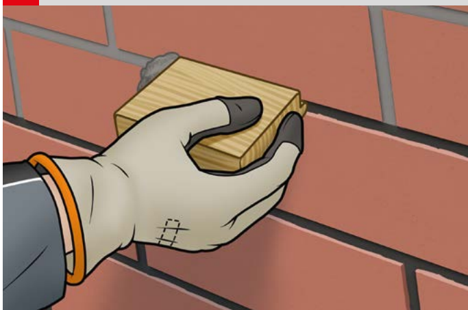
3 Usuwanie zaprawy murarskiej na głębokość ok. 10-15 mm
