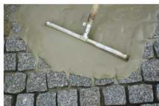
3. Wypełnianie spoin zaprawą tubag PFH skośnie do przebiegu spoin
