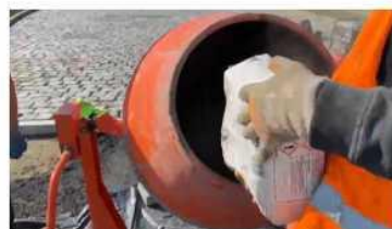
2. Przygotowanie zaprawy w betonie lub w kaskcie budowlanej z użyciem wolnoobrotowego mieszadła
