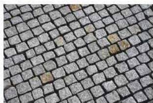
1. Oczyszczona i nawilżona nawierzchnia z kostki brukowej, o różnej szerokości szczelin, przygotowana do fugowania
