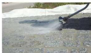
6. Zmywanie zaspoinowanej powierzchni po wstępnym związaniu zaprawy fugowej
