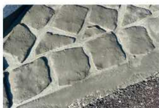
5. PFH tubag jest zaprawą szybkowiązającą, stopień związania spoiny należy sprawdzić kciukiem
