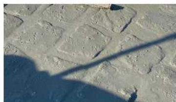
4. Zaprawa PFH łatwo wypełnia szczeliny dzięki doskonałemu rozplywowi
