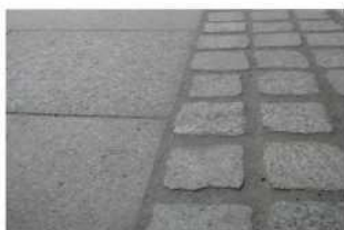
7. Zafugowana nawierzchnia brukowa
