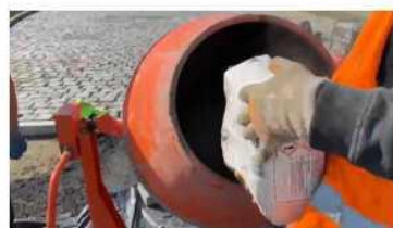
2. Przygotowanie zaprawy w betonie lub w kastrze budowlanej z użyciem wolnobrotowego mieszadła
