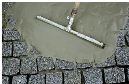
Spoinowanie i zmywanie zaprawy quick-mix/tubag PFF z formułą ECT (Easy Clean Technology)
