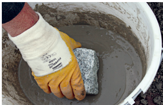
Szlam kontaktowy TNH-rapid ułatwia mocowanie oraz wzmacnia połączenie kamienia do warstwy drenażowej
