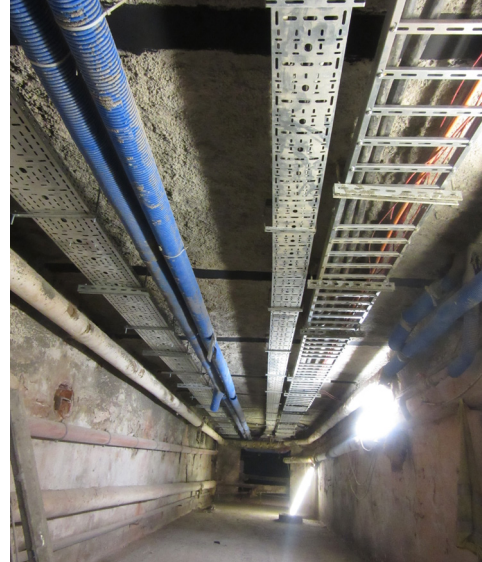
Strop nad korytarzem piwnicy po naprawie
