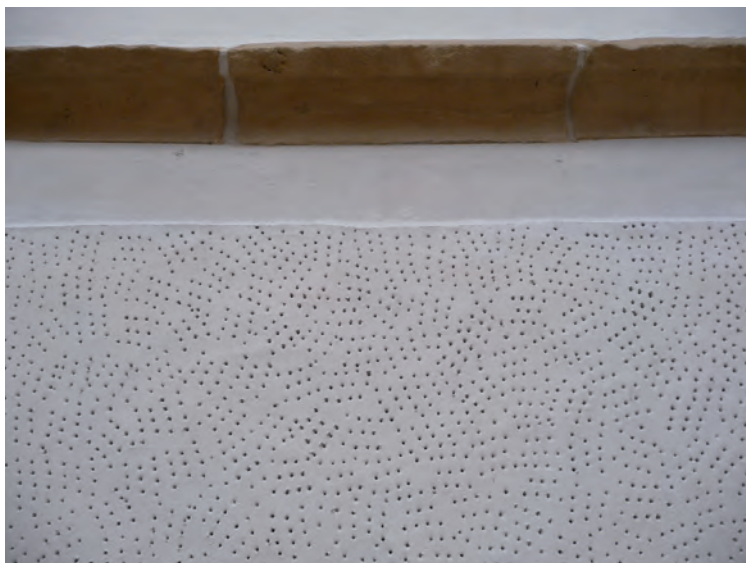
Powierzchnia Historycznego tynku wapiennego NHL-P po nadaniu faktury poprzez nakłuwanie.
