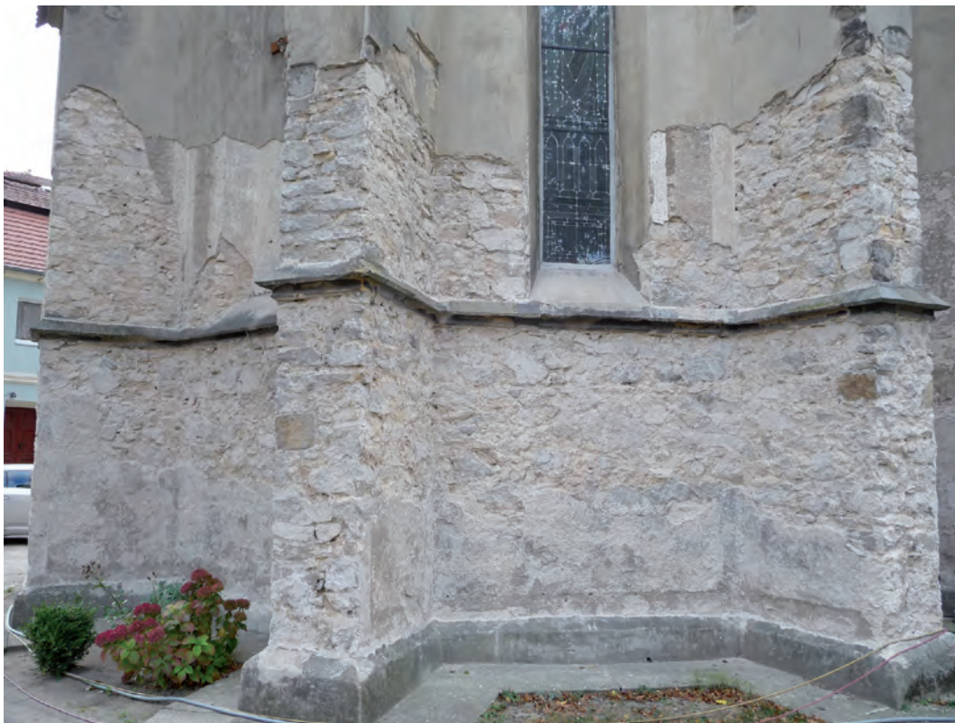
Po usunięciu mocnego tynku cementowego ukazały się mury kamienne pokryte tynkiem wapiennym oraz detale architektoniczne.
