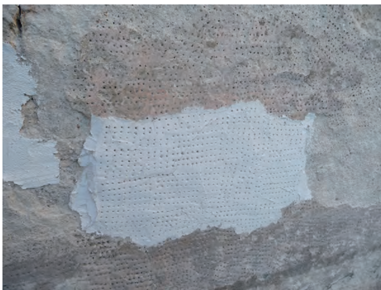
Nieudana próba uzupełniania tynku. Zastosowano drobnoziarnistą zaprawę wapienną – tynk maszynowy. Po kilkunastu dniach pojawiły się liczne spękania na powierzchni tynku.
