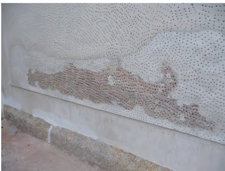
Fragment ściany. Widoczny oryginalny tynk wapienny, uzupełnienia z Historycznego tynku wapiennego NHL-P.
