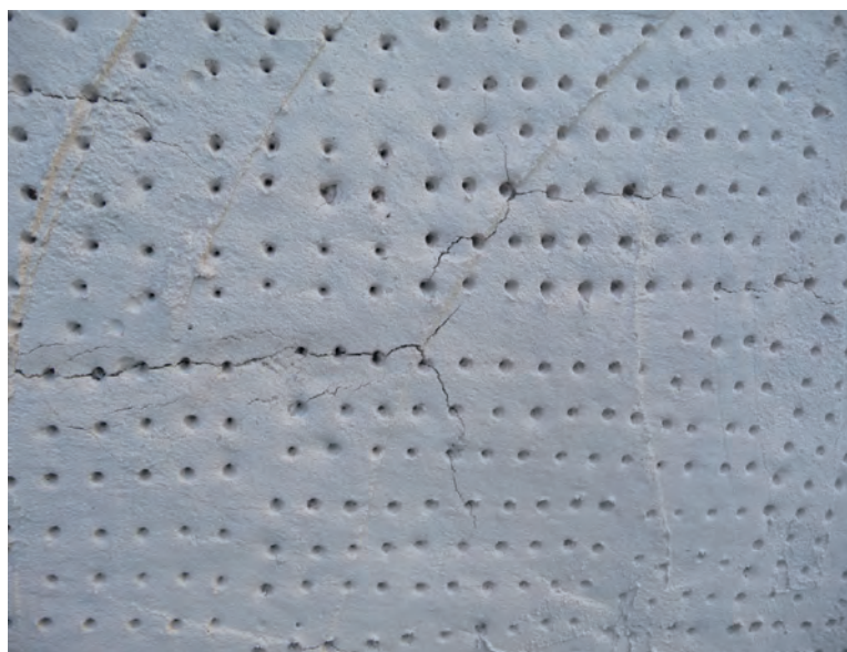
Nieudana próba uzupełniania tynku. Zastosowano drobnoziarnistą zaprawę wapienną – tynk maszynowy. Po kilkunastu dniach pojawiły się liczne spękania na powierzchni tynku.
