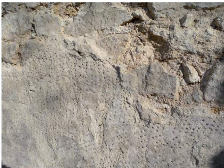
Charakterystyczny sposób fakturowania oryginalnego tynku wapiennego poprzez nakłuwanie
