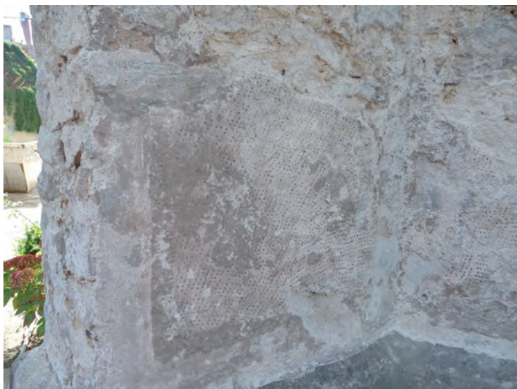
Charakterystyczny sposób fakturowania oryginalnego tynku wapiennego poprzez nakłuwanie
