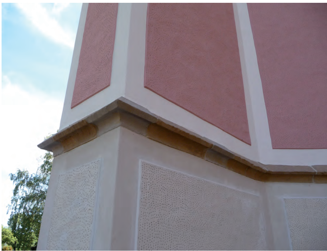
Widok przypory otynkowanej tynkami wapiennymi TUBAG. Powyżej gzymsu tynki pomalowane farbą krzemianową.
