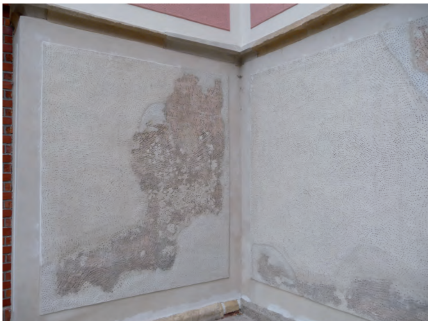
Fragment ściany. Widoczny oryginalny tynk wapienny, uzupełnienia z Historycznego tynku wapiennego NHL-P.
