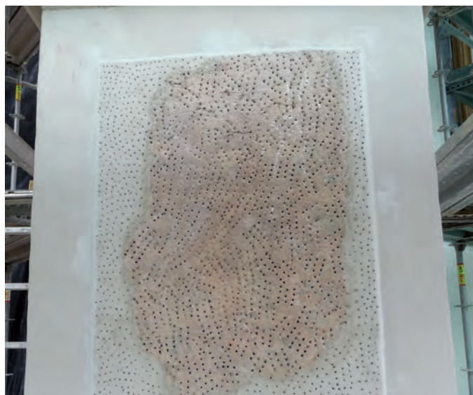
Przypora. Widoczny oryginalny tynk wapienny, uzupełnienia z Historycznego tynku wapiennego NHL-P oraz naroża pokryte Wapienną zaprawą szpachlową NHL-FP.
