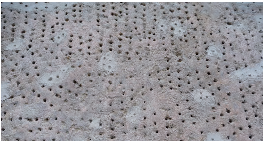
Fragment ściany. Widoczny oryginalny tynk wapienny, uzupełnienia z Historycznego tynku wapiennego NHL-P.
