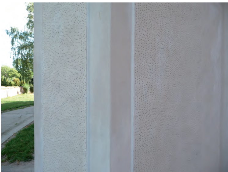
Naroża przypory pokryte Wapienną zaprawą szpachlową NHL-FP.
