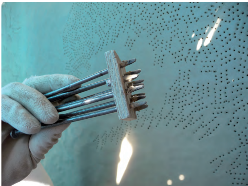
Sposób fakturowania powierzchni Historycznego tynku wapiennego NHL-P.
