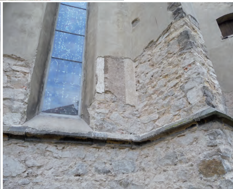
Po usunięciu mocnego tynku cementowego ukazały się ściany pokryte tynkiem wapiennym, gładkie detale architektoniczne, jak również charakterystyczne nakłucia powierzchni tynku.
