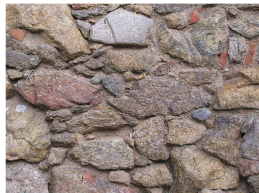
Kamienna ściana kamieniczki przed ociepleniem. Ściany parteru kamieniczki ocieplono tynkiem ciepłochronnym TMD.
