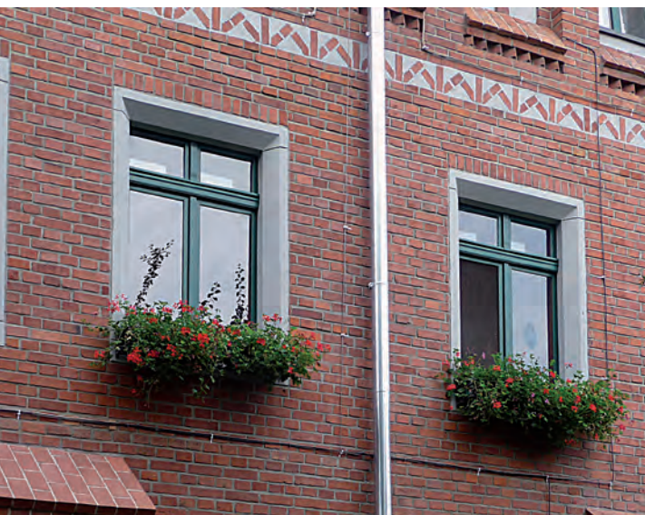
Ceglana elewacja po renowacji.
