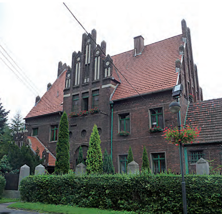
Ceglana elewacja przed renowacją.
