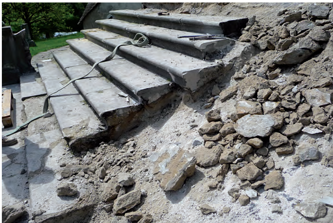
Schody wejściowe podczas demontażu.
