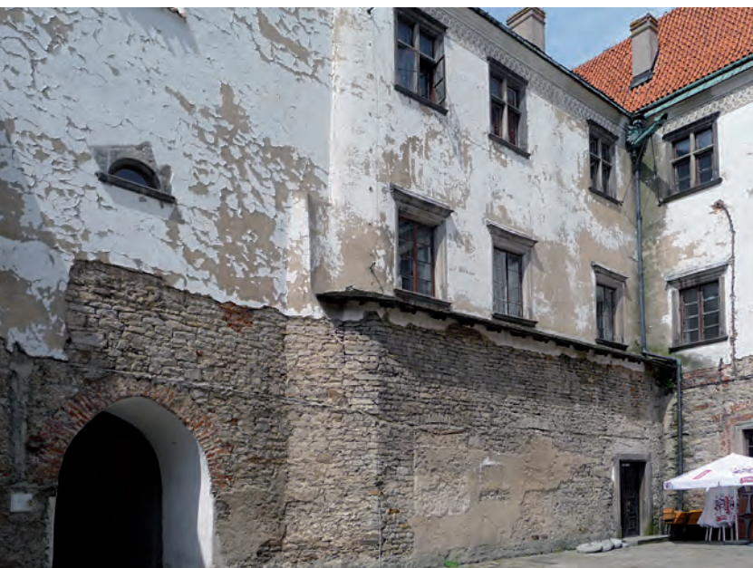
Elewacja przed i po remoncie.
