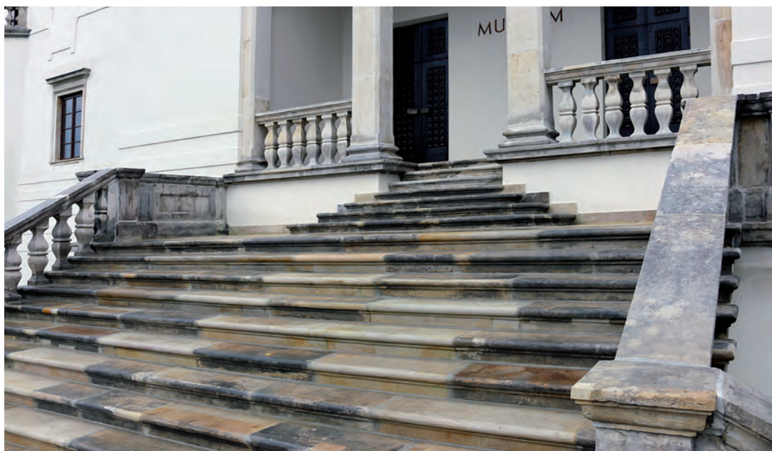
Schody po remoncie.
