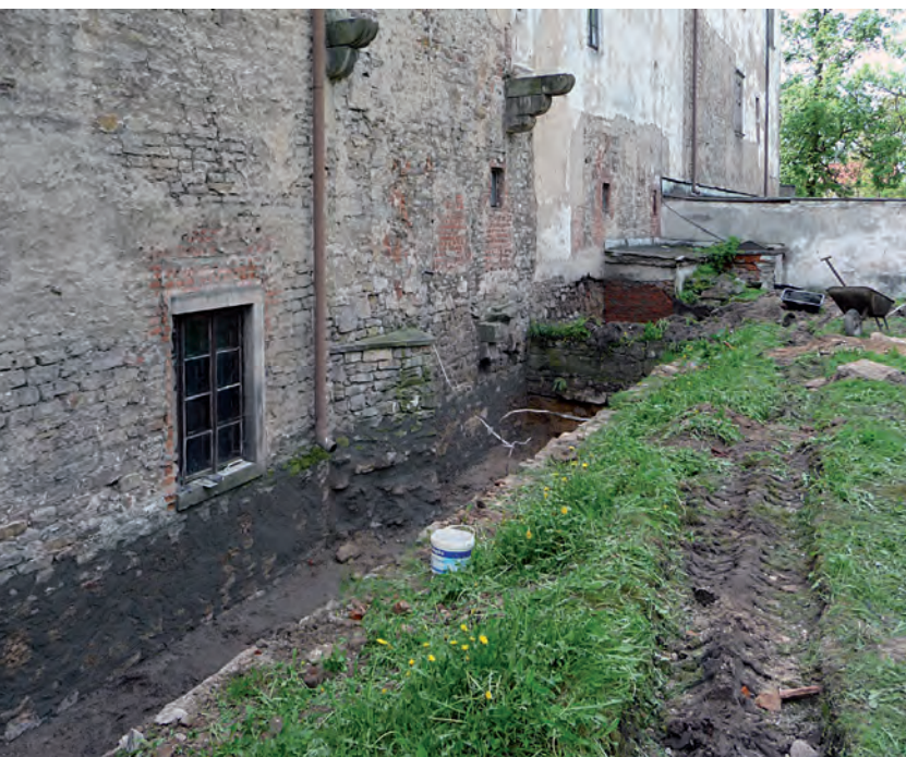
Przygotowanie ściany do wykonania izolacji pionowej.
