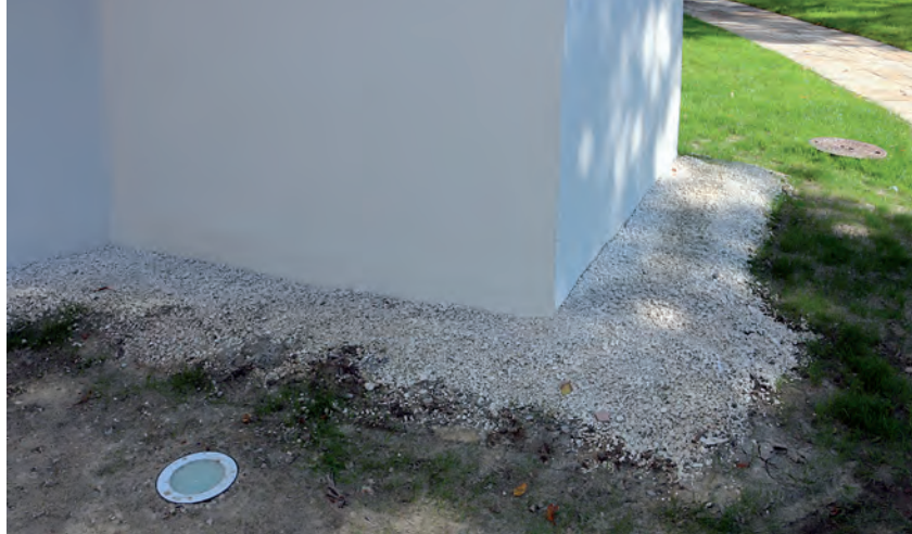
Obsypka żwirowa ścian przyziemia.
