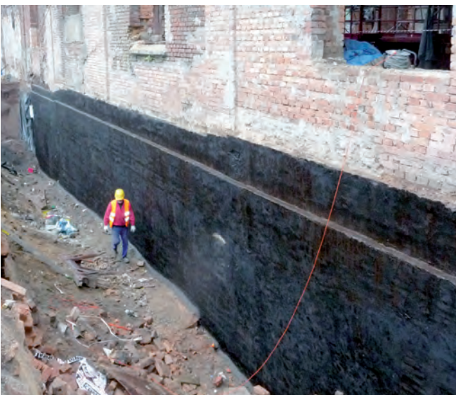
Ściana fundamentowa po wykonaniu izolacji pionowej z masy bitumicznej BD 1K.
