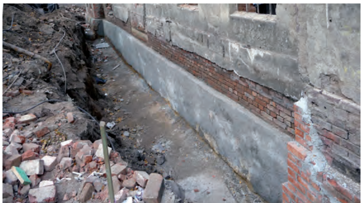
Ścian fundamentowa po wyrównaniu zaprawą tynkarską K01.
