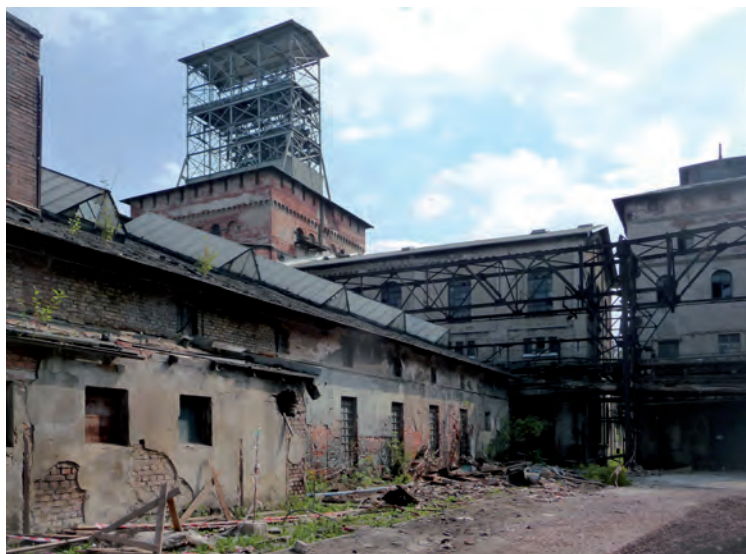
Stan techniczny budynków przed remontem.
