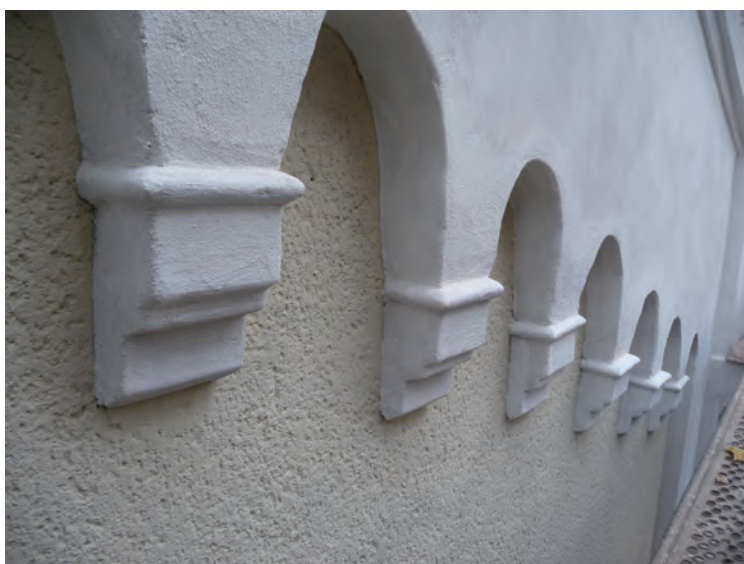
Fryz po rekonstrukcji. Widoczne powtarzalne detale odlane z zaprawy S-FIX.
