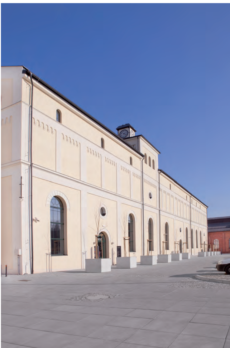
Elewacja budynku po renowacji. Tynki renowacyjne quick-mix pomalowane farbą LK 300
