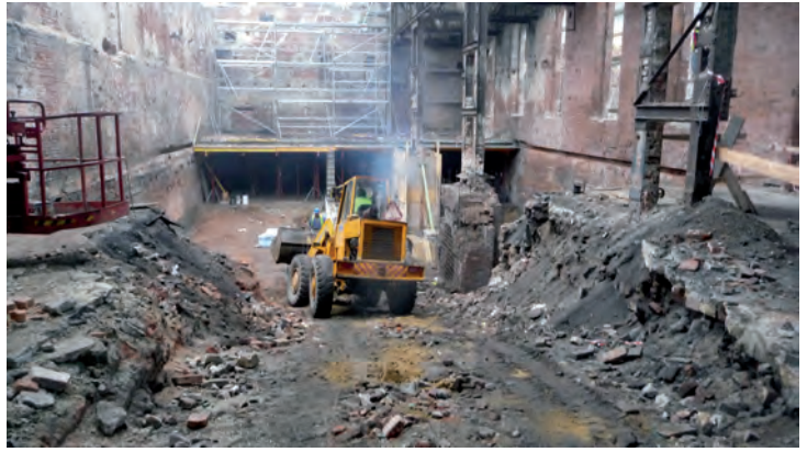
Odgruzowywanie zasypianych piwnic.
