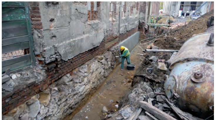
Czyszczenie kamiennych ścian fundamentowych.
