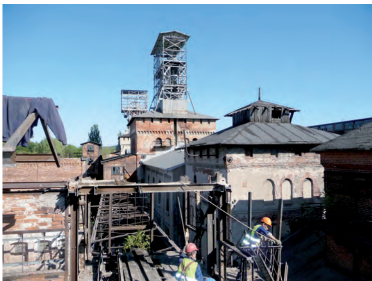
Stan techniczny budynków przed remontem.
