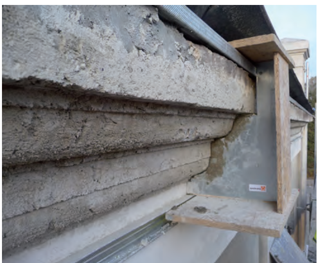
Odtwarzanie gzymsów przy użyciu zaprawy Stukoplan oraz wzorników przesuwanych po prowadnicach.
