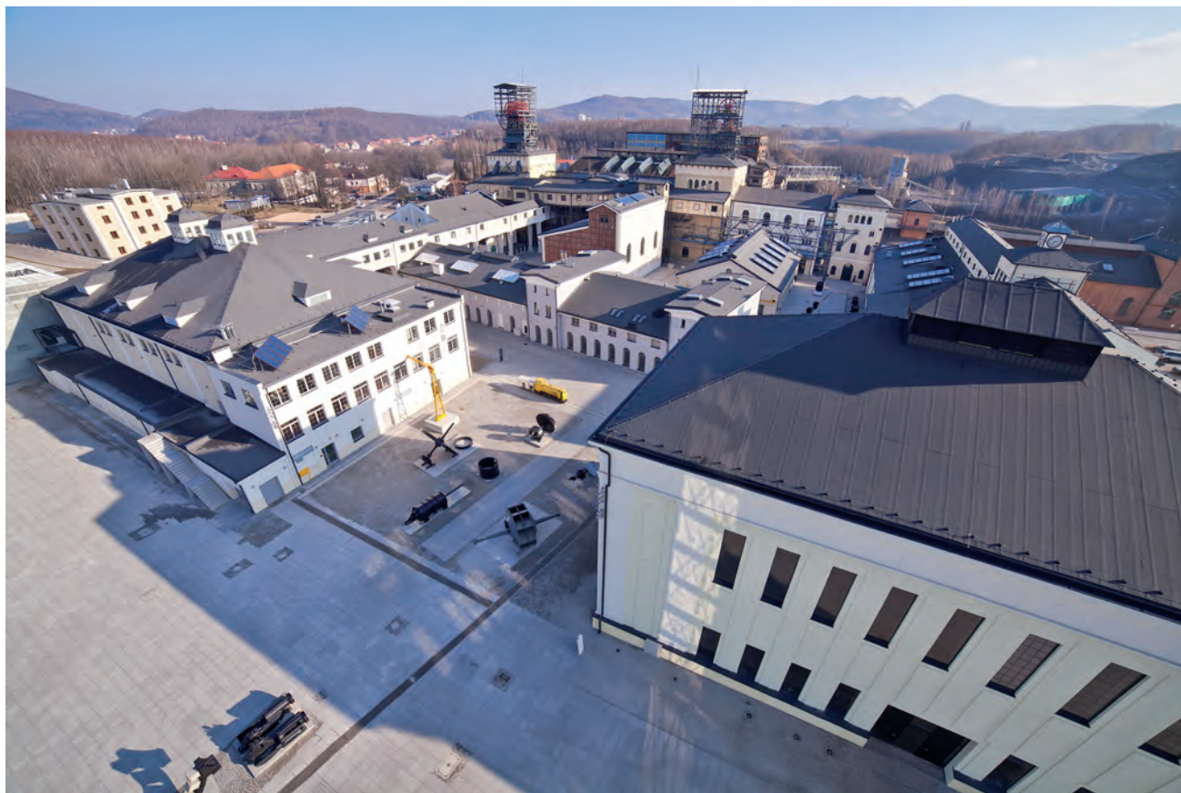
Stara Kopalnia, wejście główne.
