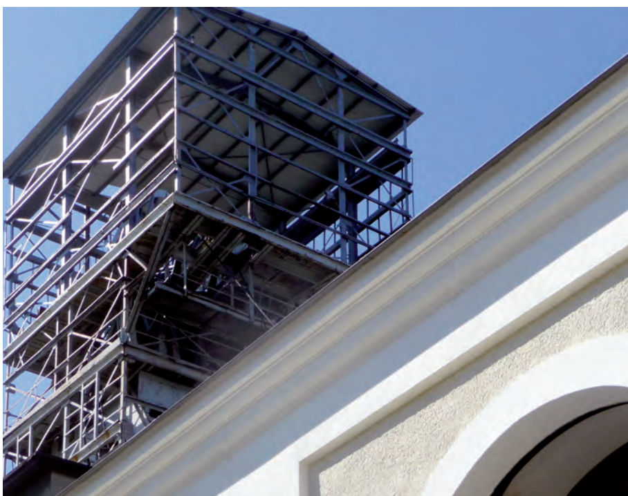
Fryz po rekonstrukcji. Widoczne powtarzalne detale odlane z zaprawy S-FIX.
