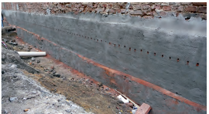
Ścian fundamentowa po wyrównaniu zaprawą tynkarską K01.
