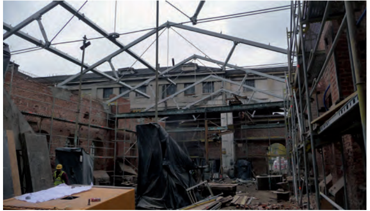
Montaż nowych stalowych więzarów dachowych.
