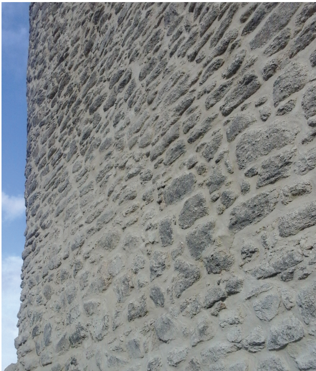
Mur zamku Chojnik po zakończeniu prac remontowych.
