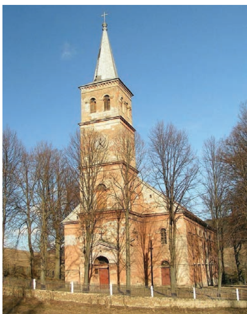
Kościół przed remontem elewacji.
