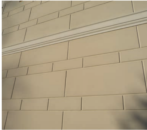
Nowe tynki boniowane, nowa powłoka malarska.
