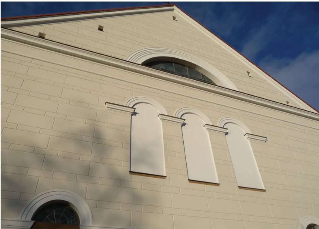
Nowe tynki boniowane, opaski okienne oraz gzymsy.
