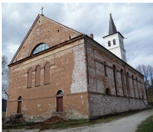
Odtworzone tynki boniowane (fot. po prawej).
