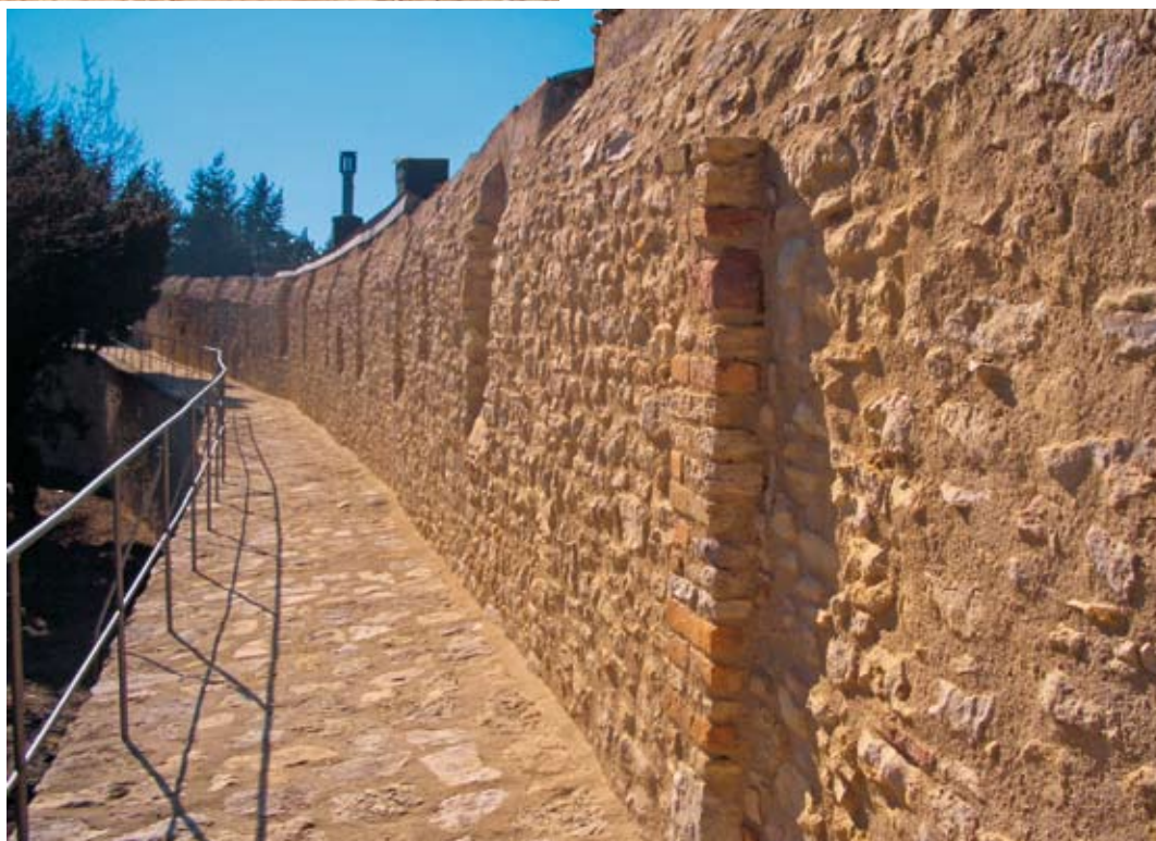
Pałac cesarski, Ingelheim, renowacja murów – TKF Zaprawa wapienno-trasowa do spoinowania.
