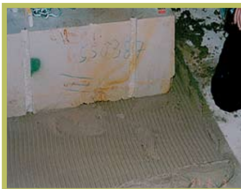
Fot. D Montaż filarów nośnych kościoła. Bloki z piaskowca osadzano na warstwie zaprawy murarskiej TWM-s. Spoiny pionowe zalewano zaprawą TZV-p.
