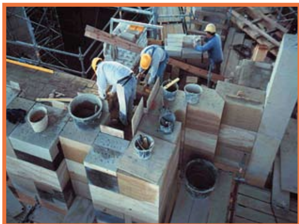
Fot. A Ściany kościoła. Od wewnątrz mur wznoszony tradycyjnie na zaprawie murarskiej TWM-s. Od zewnątrz mur licowano blokami piaskowca, spoiny poziome i pionowe zalewano zaprawą TZV-p.
