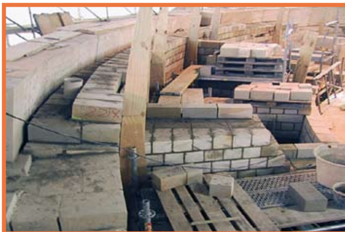
Fot. B Kopuła kościoła. Od wewnątrz kopuła wznoszona tradycyjnie na zaprawie murarskiej TWM-s. Od zewnątrz kopułę licowano blokami piaskowca, spoiny poziome i pionowe zalewano zaprawą TZV-p.
