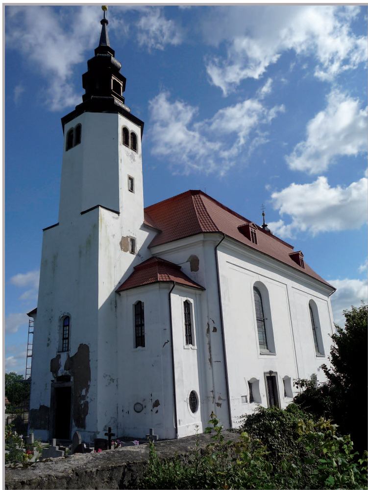
Kościół przed remontem elewacji.
