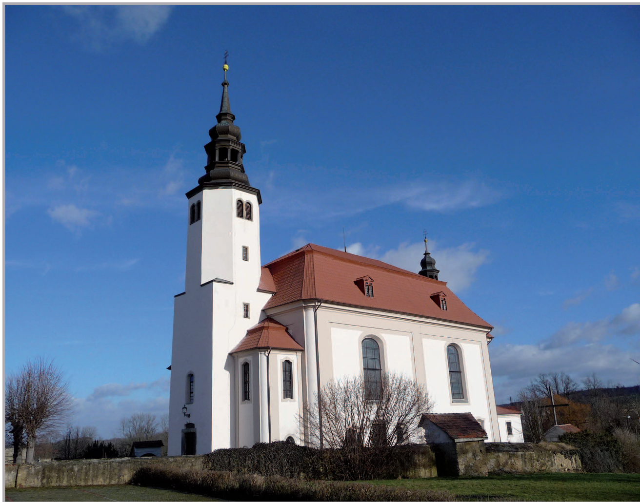
Elewacja kościoła po przeprowadzonym remoncie.
