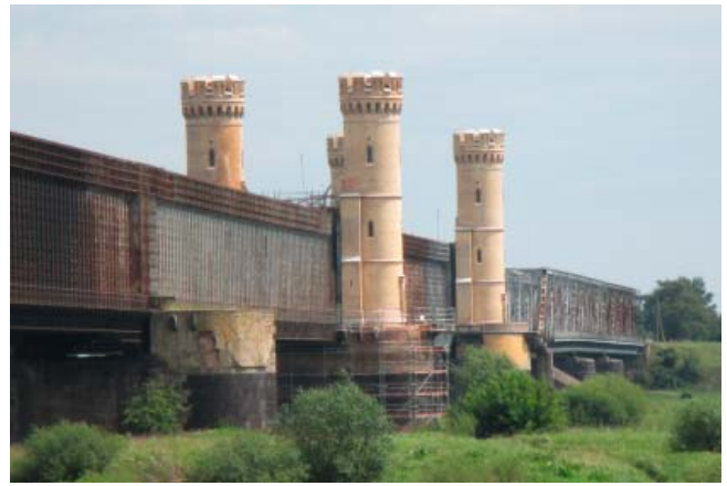
Fot. 3. Most Lisewski w Tczewie
