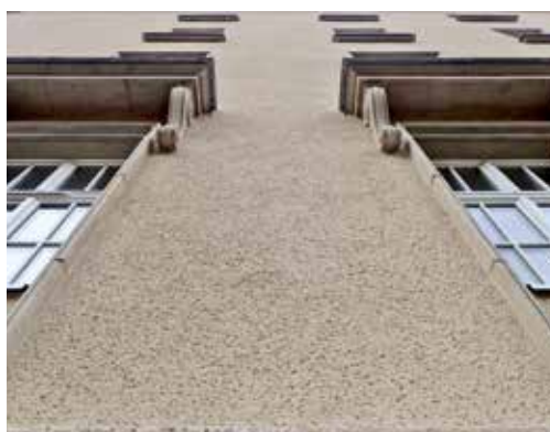
Elewacja po otynkowaniu tynkiem cyklinowanym.
