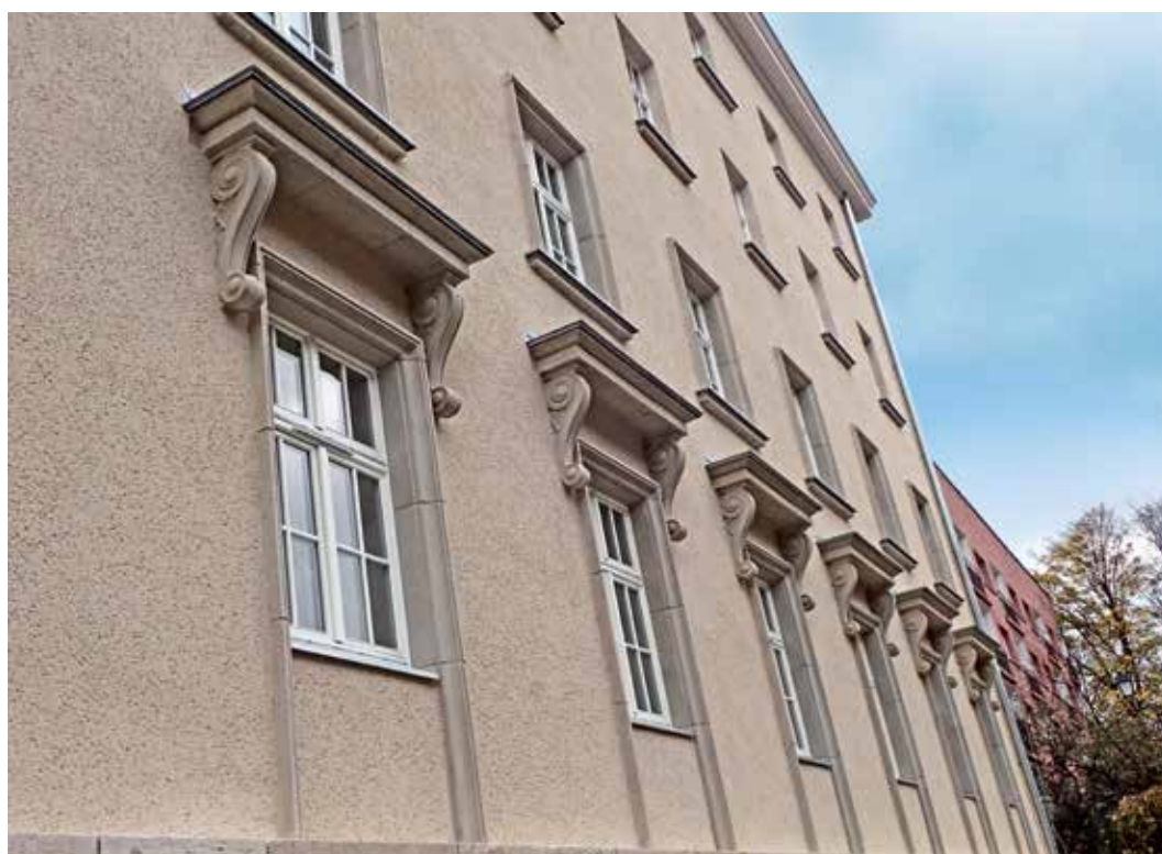
Elewacja po otynkowaniu tynkiem cyklinowanym.
