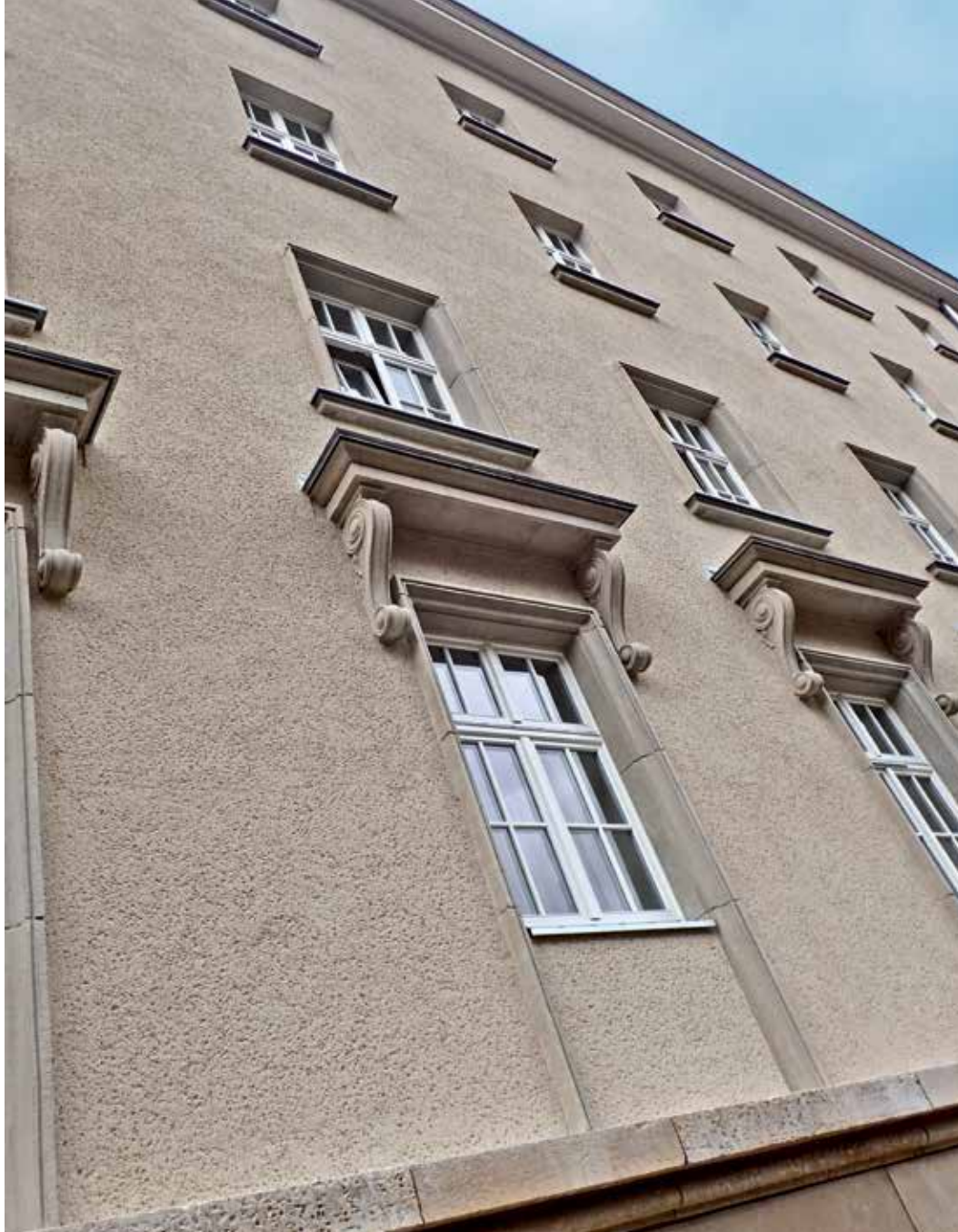
Elewacja po otynkowaniu tynkiem cyklinowanym.
