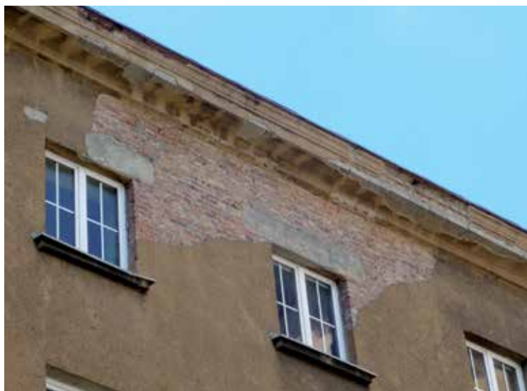
Uszkodzenia tynków elewacyjnych.
