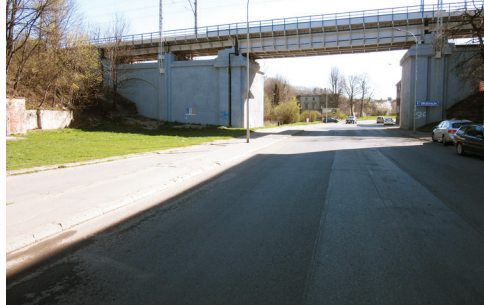
Wiadukt kolejowy w Wałbrzychu po naprawie
