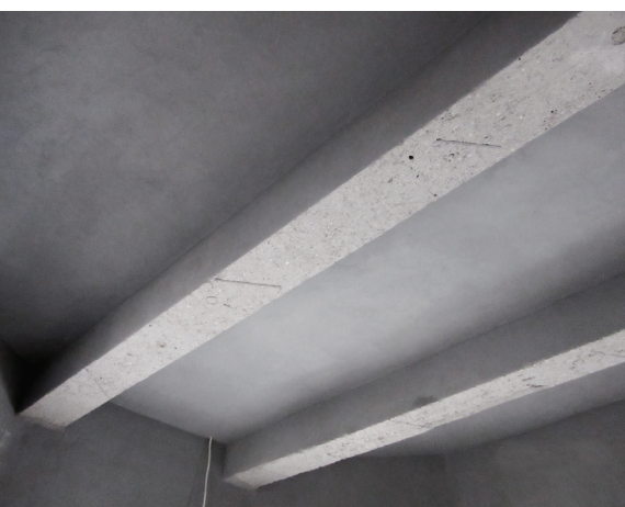
Strop dzwonnicy po wykonaniu torkretu
