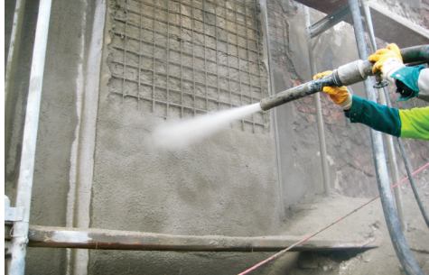
Natrysk torkretu podczas naprawy wiaduktu w Wałbrzychu
