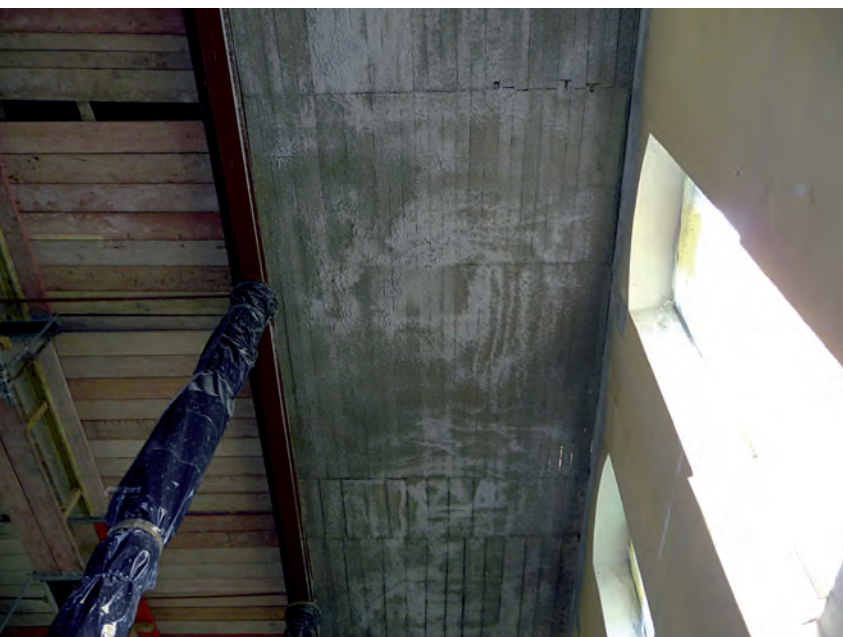
Warstwa szepna, obrzutka z zaprawy MZ 4.
