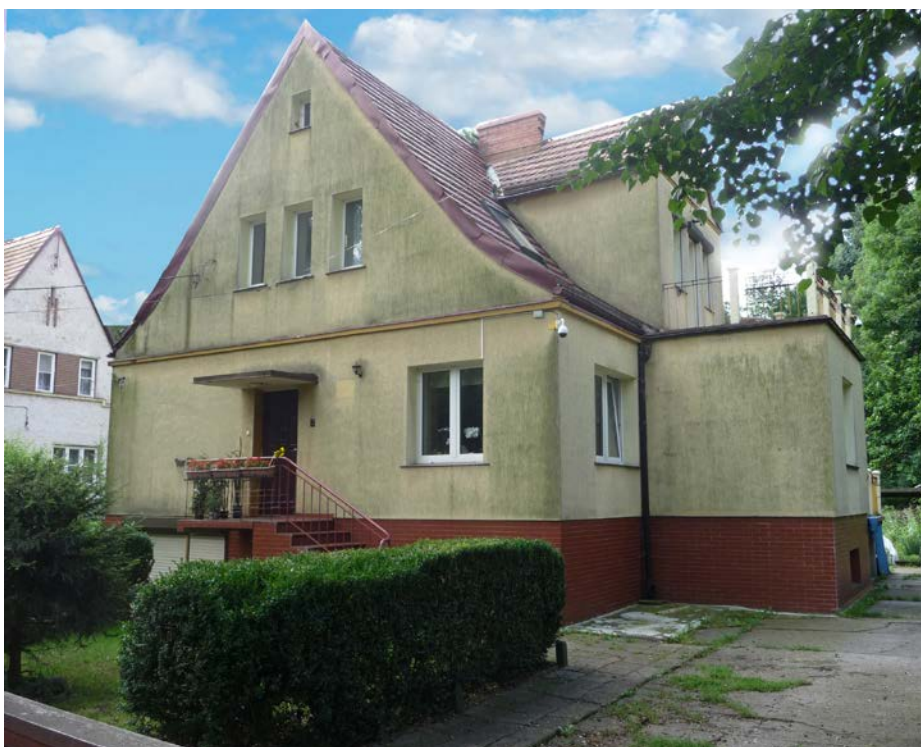
Fot 2. Fasada porażona przez glony i grzyby-pleśnie
